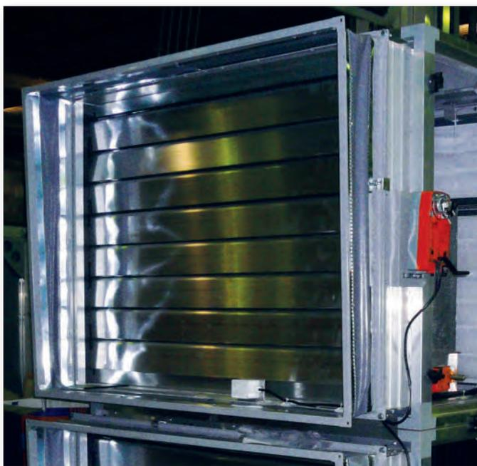
Регулирующие воздушные клапаны служат для приема и/или смешения воздуха, поступающего в кондиционер. Клапан может устанавливаться на передней панели кондиционера, в приемной секции или приемно-смесительном блоке.
