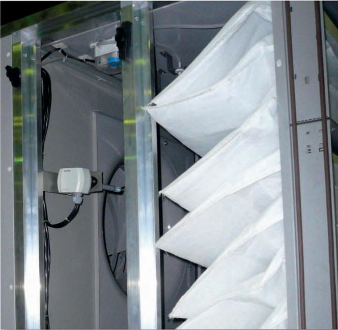
Карманные фильтры предназначены для удаления твердых и волокнистых частиц из приточного, рециркуляционного или вытяжного воздуха. Их установка обеспечивает защиту помещения от попадания различных механических примесей, содержащихся в воздухе. В карманных фильтрах площадь фильтровального материала, через которую проходит очищаемый воздух, в несколько раз больше площади фронтального сечения установки, что позволяет уменьшить аэродинамическое сопротивление фильтра, увеличить срок службы.
